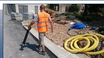
Recherche de boules marqueurs posées sur un réseau gaz PEHD
