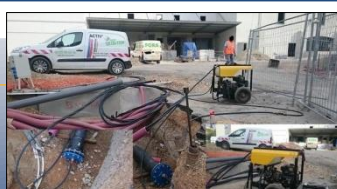
Réalisation de tests d'étanchéité sur une canalisation d'eau potable en PEHD Ø250
