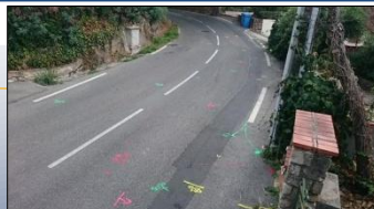
Investigation complémentaire dans le cadre de travaux AEP : détection des réseaux gaz, électricité. Orange
